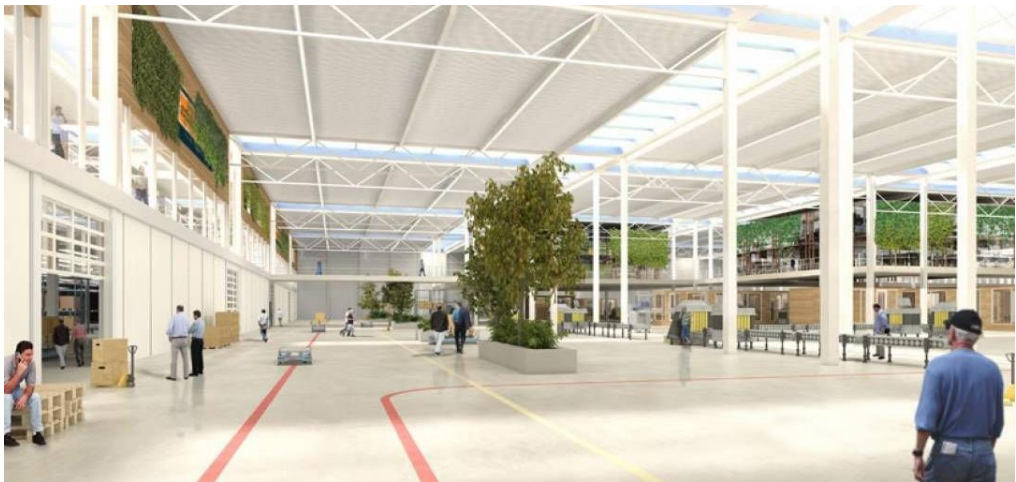
HET BIC GEBOUW IN EINDHOVEN BETREFT EEN MODULAIR GEBOUW DAT AANGEPAST KAN WORDEN AAN DE WENSEN VAN EEN BEDRIJF. TUSSEN DE BASEELEMENTEN ONTSTAAT EEN RUIMTE VAN TWINTIG BIJ TWINTIG METER, DIE AFGENOMEN KAN WORDEN IN DE GEWENSTE AANTALLEN. DAARNA KAN DE HUURDER KIEZEN UIT INBOUWELEMENTEN, ZOALS LOOPBRUGGEN, VLOEREN, (GLAZEN) WANDEN EN CLEANROOMS. Bron SDK Vastgoed
